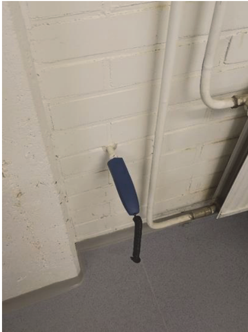
Kuva 1. Porareikämittaus kellarin seinästä.
