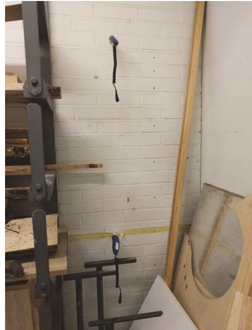
Kuva 2. Porareikämittaus kellarin seinästä.
