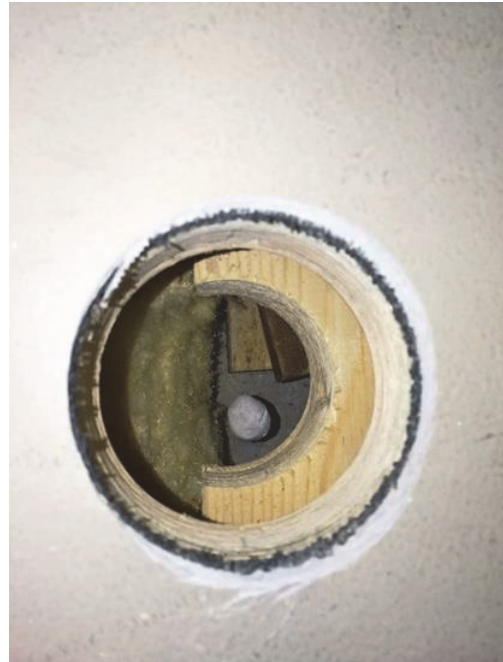
Kuva 4. Porareikämittaus liikuntasalin alapohjasta.
